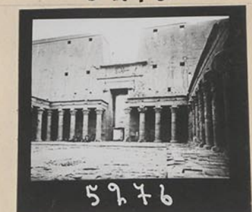
Haupttempel. Hof mit Pylon.
