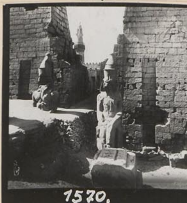
1570. Der Eingang zwischen den Pylontürmen.
