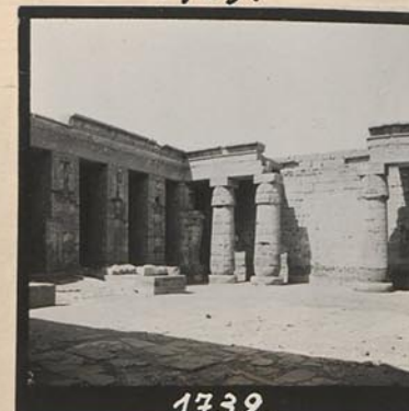
1739. Haupttempel 2. Hof, Nordwestecke
