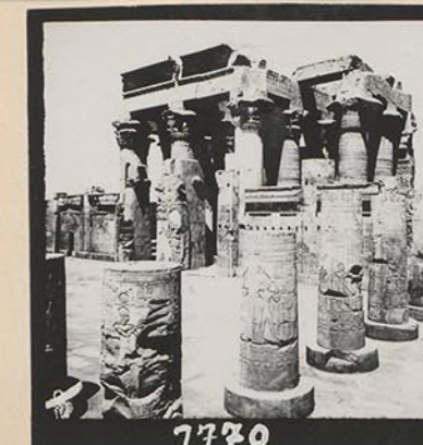
Kom Ombo, Tempel Hof + Vordelle, von der S.W. Ecke der Säulenhalle aus.
