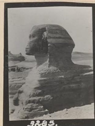
Gise. Sphinx nach der Ausbesserung.
