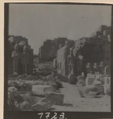
Der große Tempel. 7. und 8. Pylon von N. gesehen.
