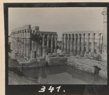
341. Säulenhof und -halle Amenophis' III.
