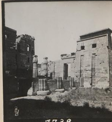
1738. Kleiner Tempel 2. Pylon von N. O.
