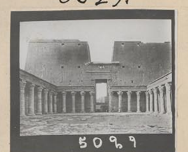
Haupttempel Hof mit Pylon
