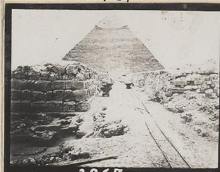
Gise. Gräberstraße im West- friedhof (nördl. von Chephren).
