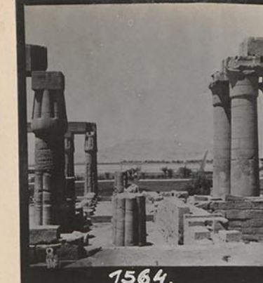
1564. Blick vom Tempel auf das gegenüber Ufer
