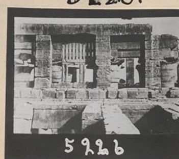
Großer Säulensaal Fenster
