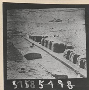
5158. Ferchan Mastaba 2038, Ostseite.
