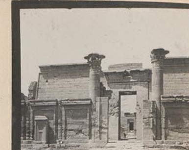
1730. Kleiner Tempel Späte Pylonen i. Hof und i. Pylon
