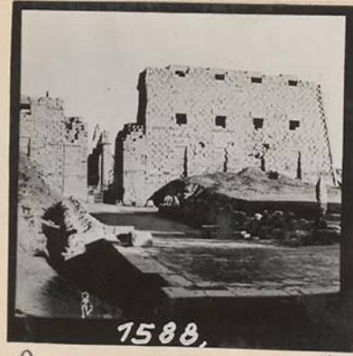
1588. Der große Tempel. Vor dem 1. Pylon.
