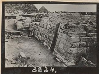
Gise. Westfriedhof. Mastaba der 4. Dyn. mit angebauter Steinkammer.
