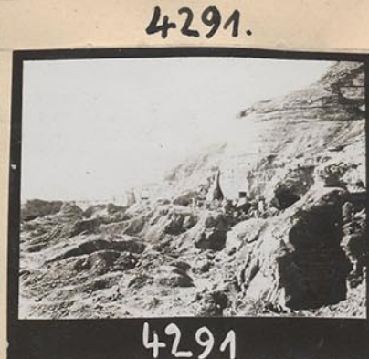
Steinbrücke bei Tura
